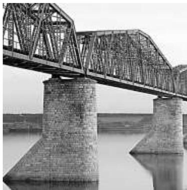
В некоторых случаях направление течения реки можно определить по опорам моста, имеющим асимметричную форму (см. фото). Объясните, какую она играет роль? В какую сторону течет река на фотографии?
